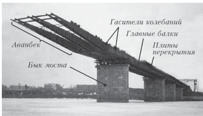
Рис. 1. Монтаж моста через реку Томь в городе Томске
